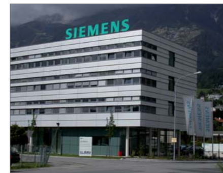
Ansicht SIEMENS Niederlassung Innsbruck
